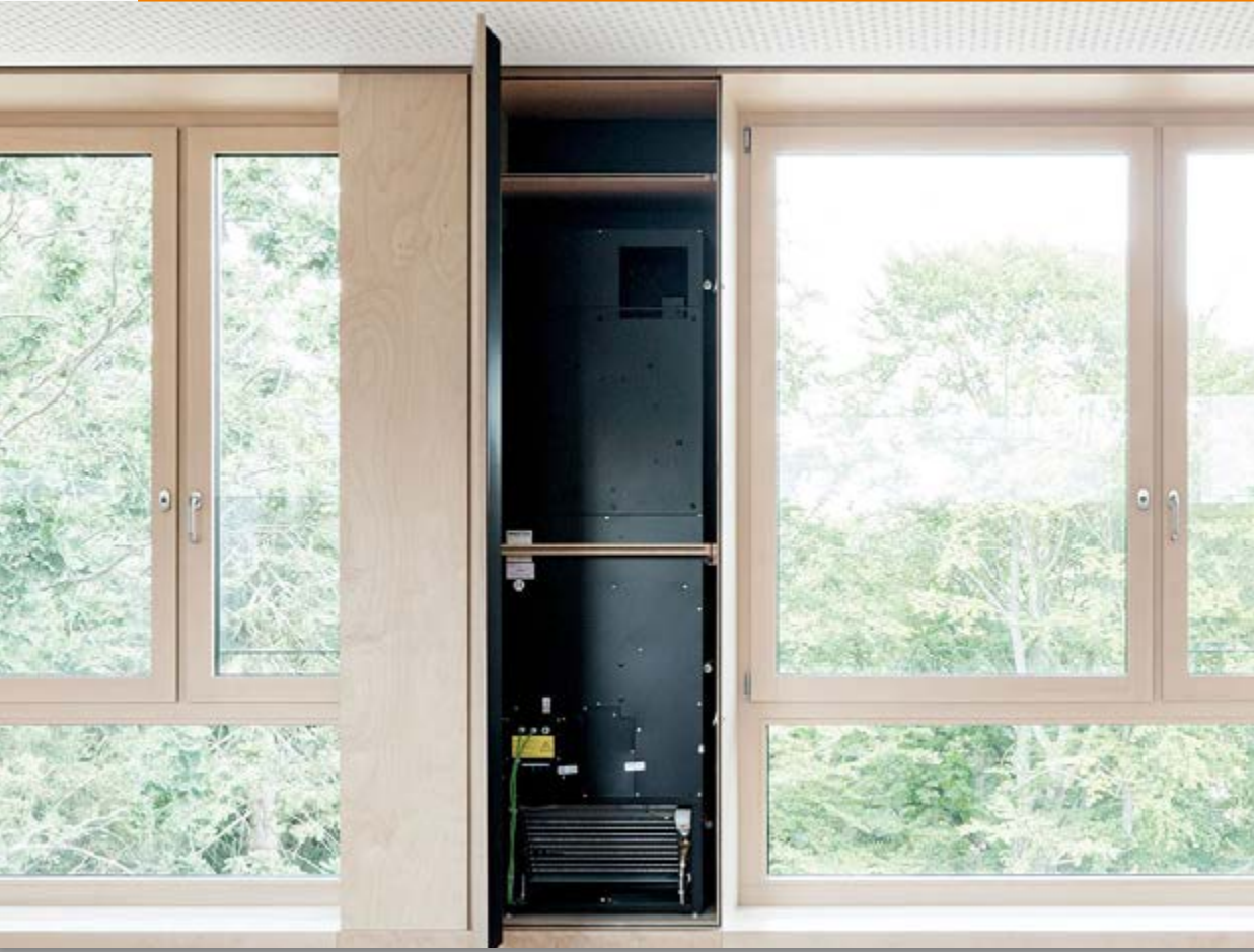
Leicht zugängliche Module. Hilfreich z. B. beim Filterwechsel.
