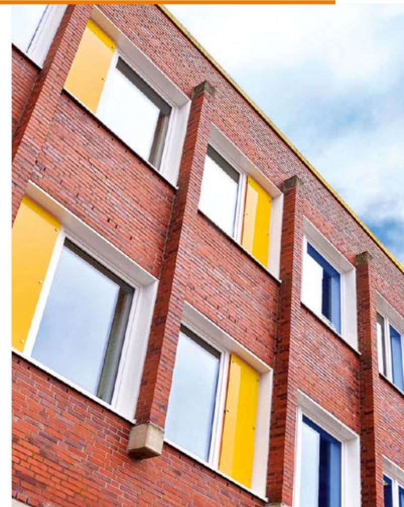
Paul-Spiegel-Berufskolleg Warendorf: Schmale Fensterelemente wurden gegen opake Elemente für die Luftführung ausgetauscht.
