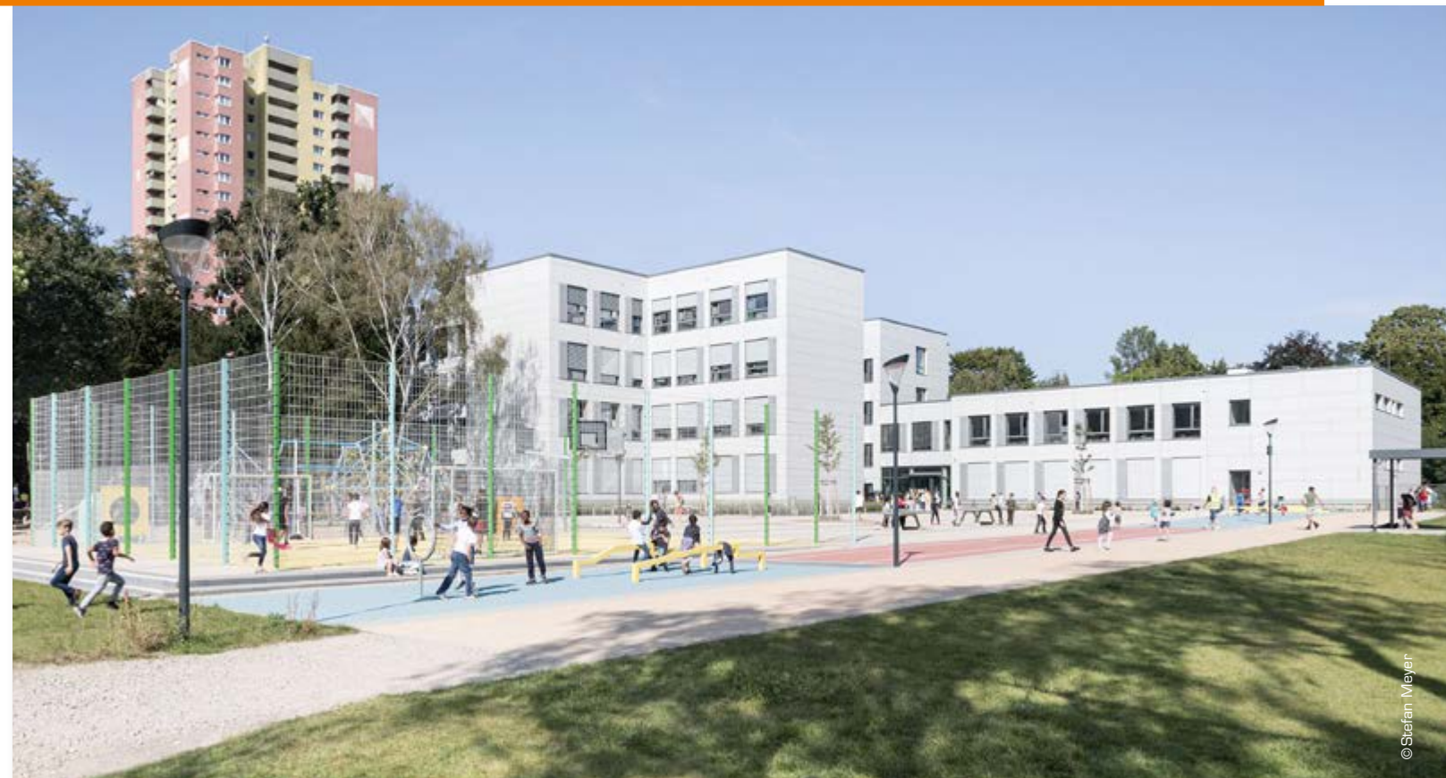
Die Marienfelder Grundschule wurde grundlegend saniert und mit modernen Lüftungsgeräten ausgestattet.
