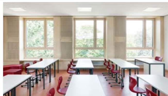
Fassadenintegrierte Lüftungsgeräte sorgen für ausreichenden Luftaustausch und gesunde Luft in den Klassenräumen.
